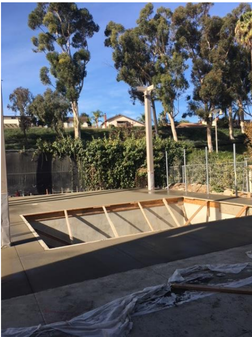
Foam Pit Deck Final Pour
