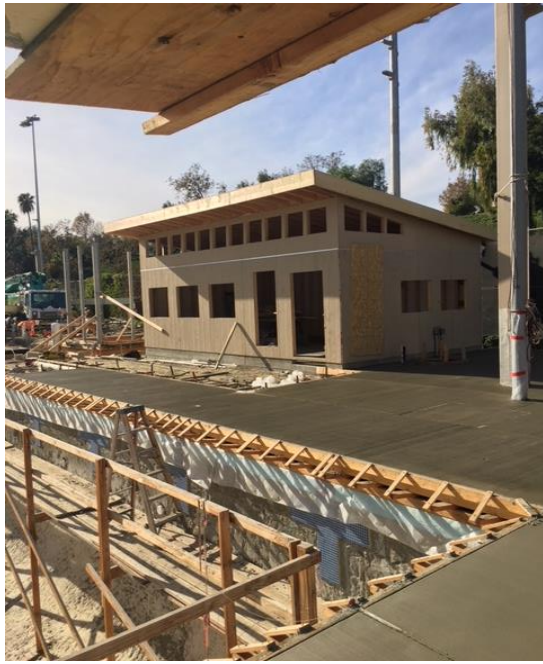
Dive Pool Office/ Deck Final Pour
